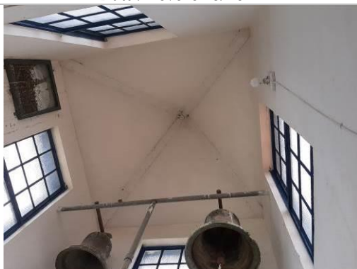
Foto 38. Vista interna das janelas da torre. Autor: Fernanda C.A.von Sperling Data: Fevereiro/2022
