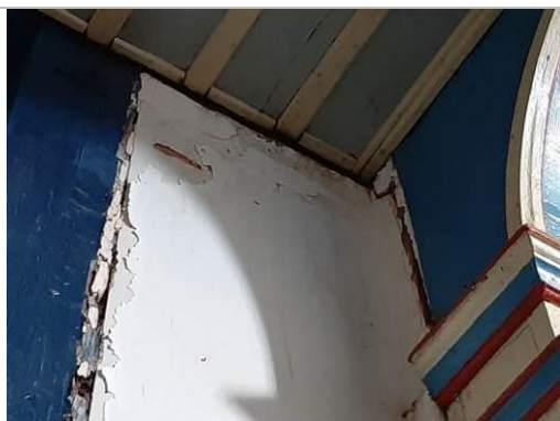
Foto 28. Descascamentos abaixo do coro. Autor: Fernanda C.A.von Sperling Data: Fevereiro/2022
