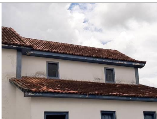
Foto 15. Vista externa do telhado Autor: Fernanda C.A.von Sperling Data: Fevereiro/2022
