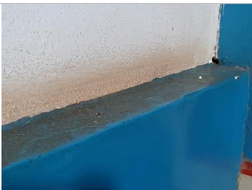
Foto 27. Mancha interna na base. Autor: Fernanda C.A.von Sperling Data: Fevereiro/2022
