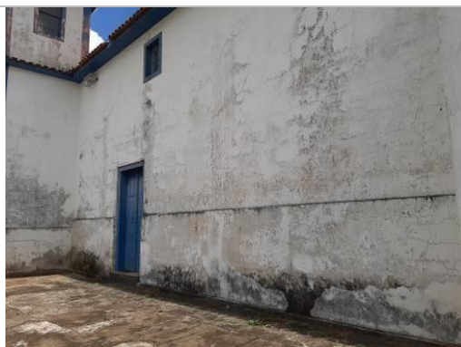
Foto 24. Danos na pintura lateral. Autor: Fernanda C.A.von Sperling Data: Fevereiro/2022
