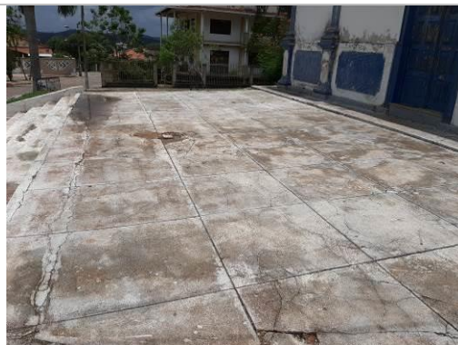
Foto 46. Piso cimentado externo.
