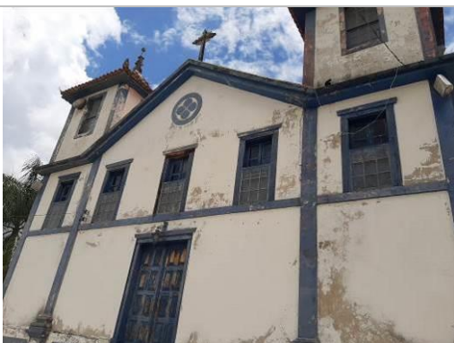
Foto 23. Vista da pintura na fachada principal Autor: Fernanda C.A.von Sperling Data: Fevereiro/2022
