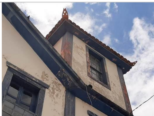
Foto 26. Descascamentos na torre. Autor: Fernanda C.A.von Sperling Data: Fevereiro/2022
