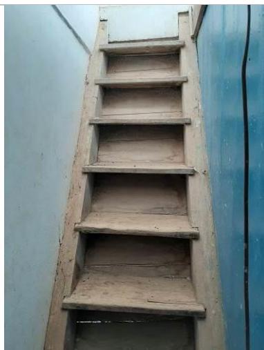
Foto 52. Escada de acesso à torre. Autor: Fernanda C.A.von Sperling Data: Fevereiro/2022
