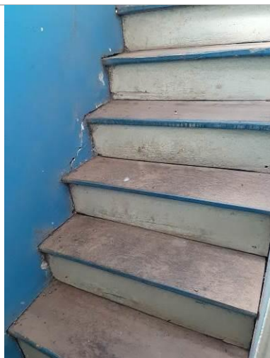
Foto 51. Escada de acesso ao coro. Autor: Fernanda C.A.von Sperling Data: Fevereiro/2022
