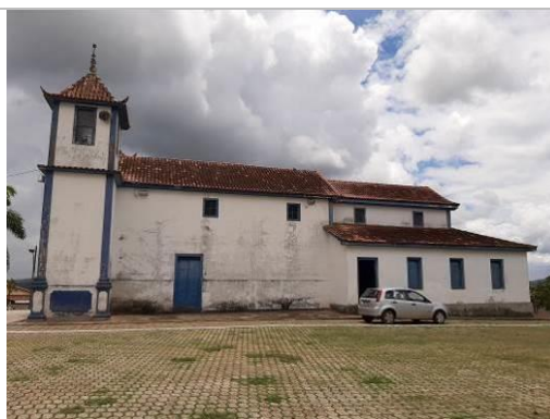
Foto 16. Vista do telhado – plano geral Autor: Fernanda C.A.von Sperling Data: Fevereiro/2022
