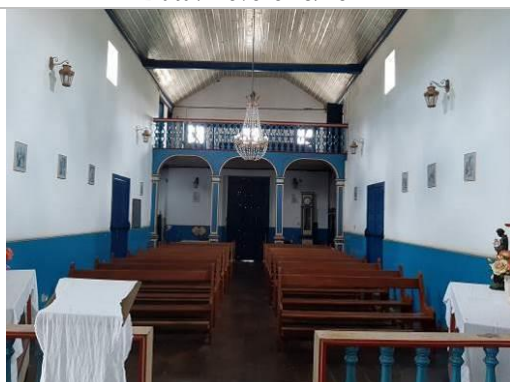
Foto 21. Vista interna da alvenaria Autor: Fernanda C.A.von Sperling Data: Fevereiro/2022
