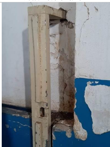
Foto 28. Descascamentos abaixo do coro. Autor: Fernanda C.A.von Sperling Data: Fevereiro/2022
