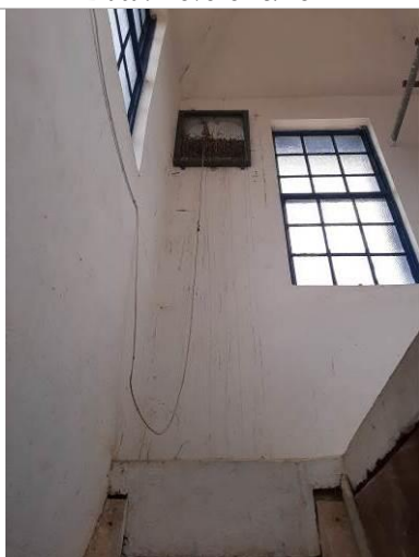
Foto 27. Mancha interna na base. Autor: Fernanda C.A.von Sperling Data: Fevereiro/2022
